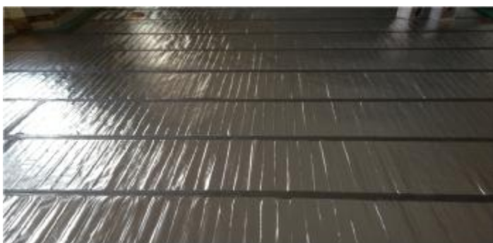
Fig. 10) Sådan kan en afsluttet AluMat installation se ud.
